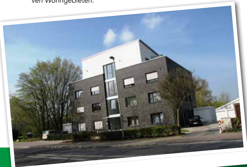
Objekt an der Dahlhauser Straße 65
